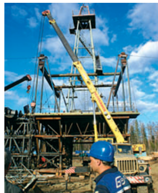
Монтаж БУ ЗД-76 на скважине № 14 Чиканской.
